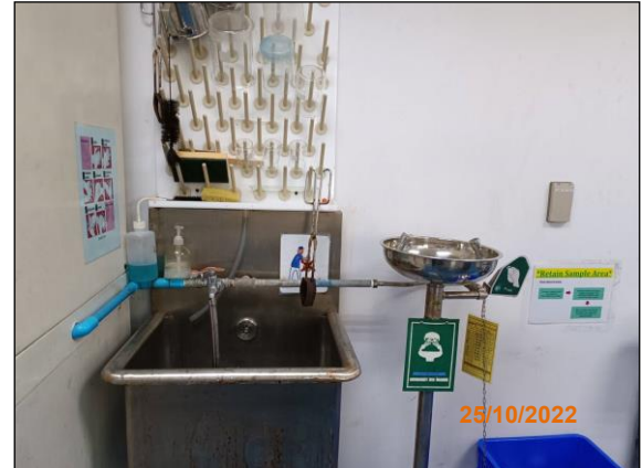
ภาพที่ 2.2-28 ฝักบัวล้างตัว และอ่างล้างตาฉุกเฉิน
