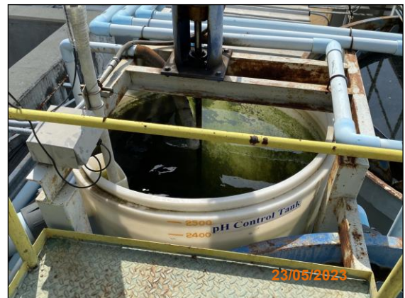
ระบบบำบัดน้ำเสียปนเปื้อนสารละลายกรด
