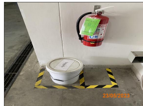
ภาพที่ 2.2-35 วัสดุดูดซับสารเคมี
