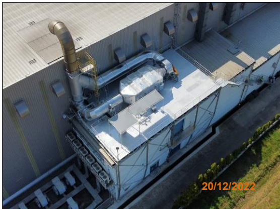
ภาพที่ 2.2-12 ระบบบำบัดอากาศแบบ Selective Catalytic Reduction (SCR)
